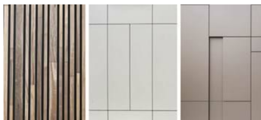
Materialevalg på tilbagetrukne/indvendige facader – træbeklædning suppleret med cement og metal.
